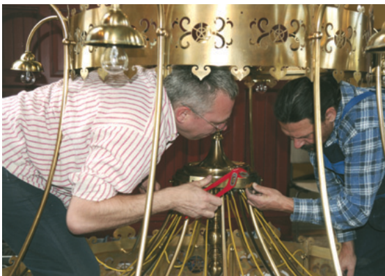
De lampen worden geplaatst.
