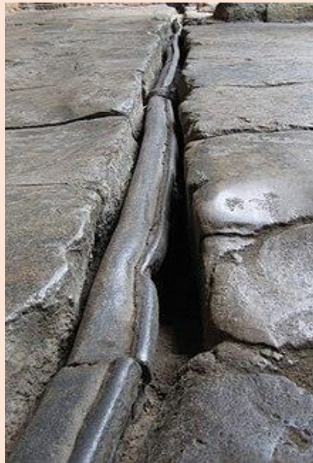
Voorbeeld van een loden waterleiding in situ (Pompeii)
